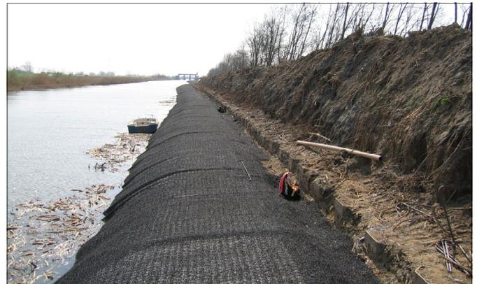
Figure 1: Utilisation de Macmat® en protection superficielle de berge
