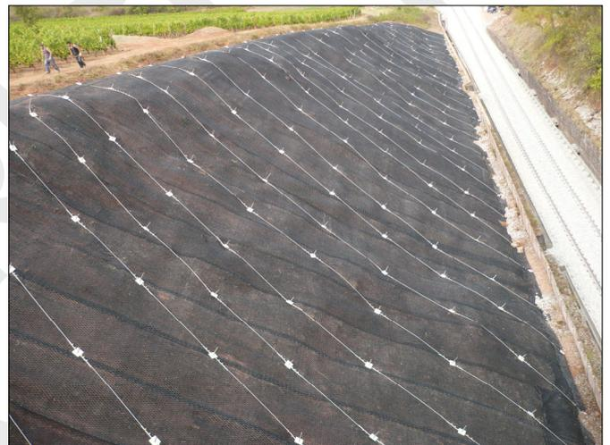
Figure 2: Utilisation de Macmat® en protection de talus cloué
