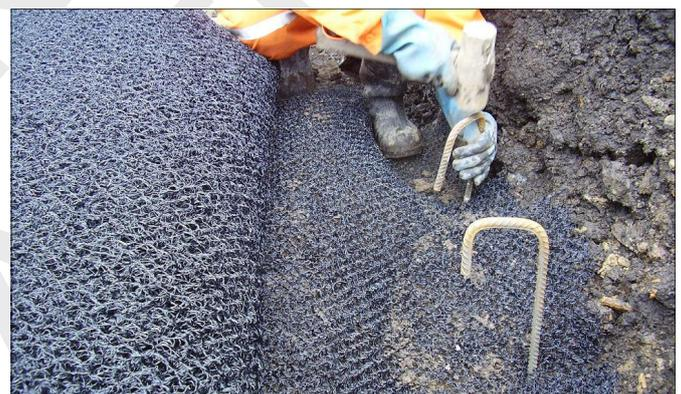
Figure 5: Détail de l'ancrage du Macmat® dans la tranchée d'ancrage
